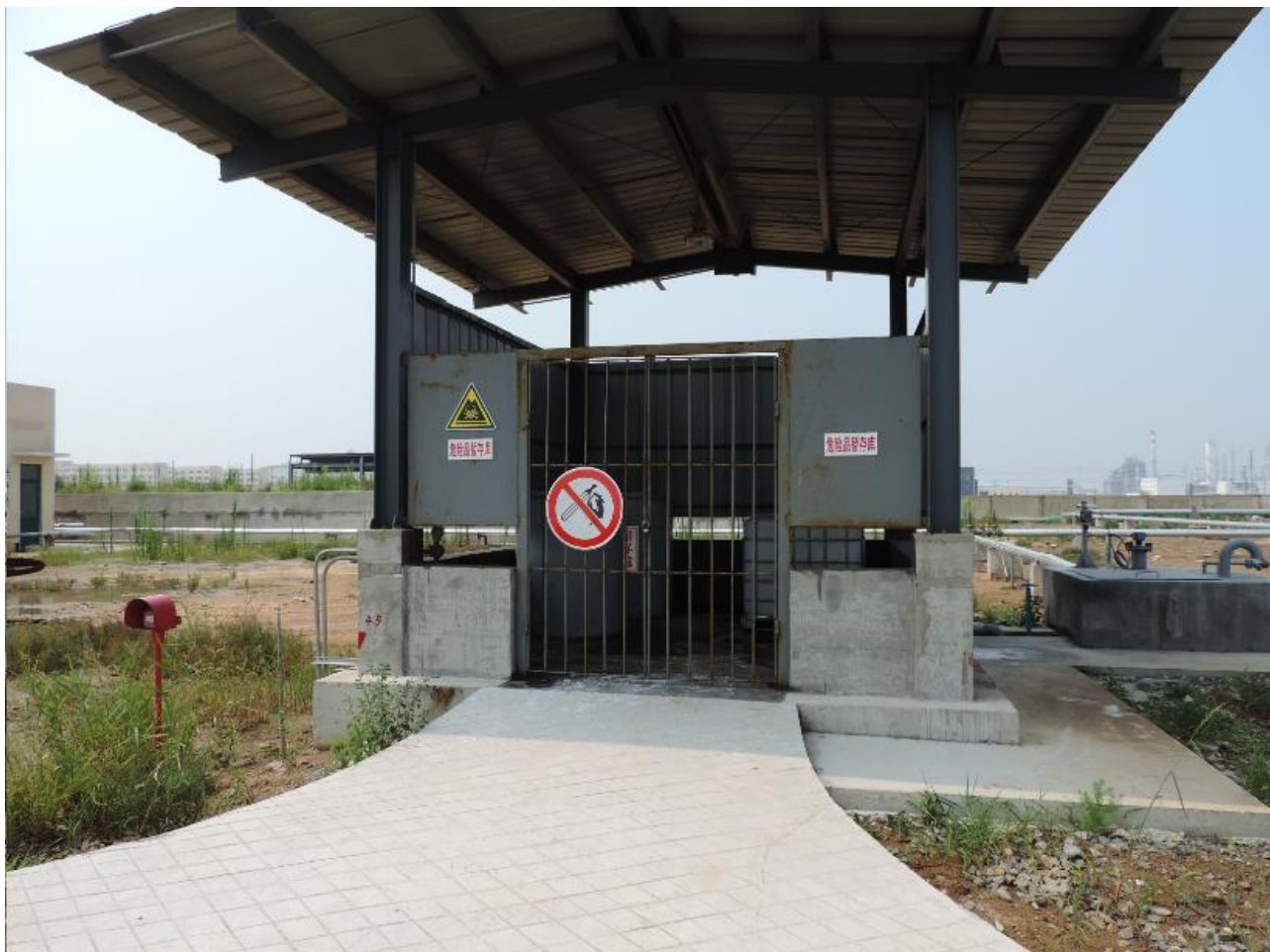
图 5.2 危废暂存仓库
