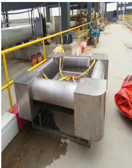
图 2.8-3 收油机及喷洒装置
