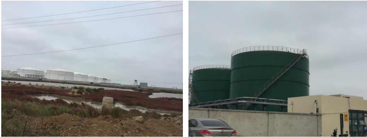
图 2.3-2 依托罐区及消防水罐
