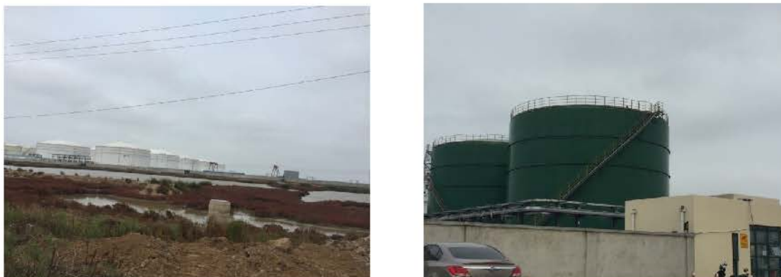
图 2.2-4 依托罐区及消防水罐
