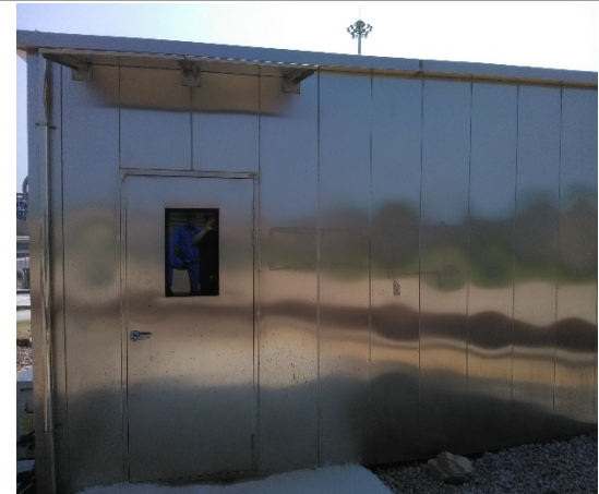
雨水在线监控室
