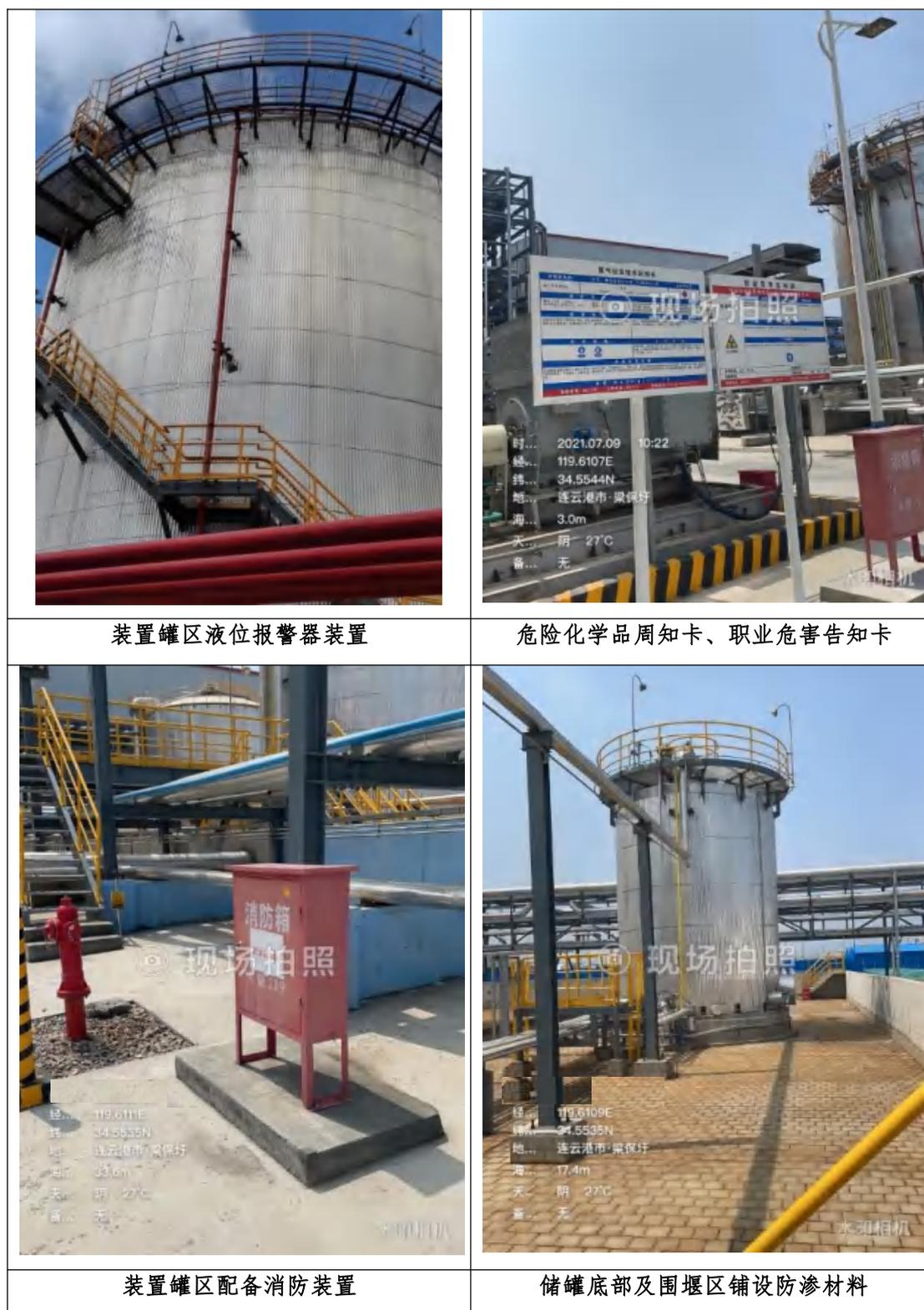
图 5.2-6 装置罐区安全、防渗防护措施
