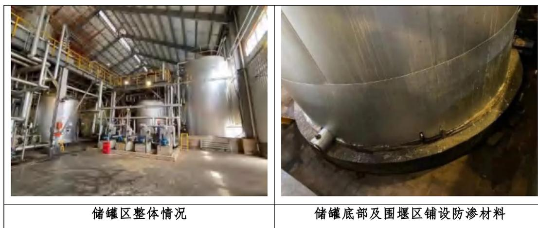
图 5.2-8 CMB 储罐土壤污染预防措施
