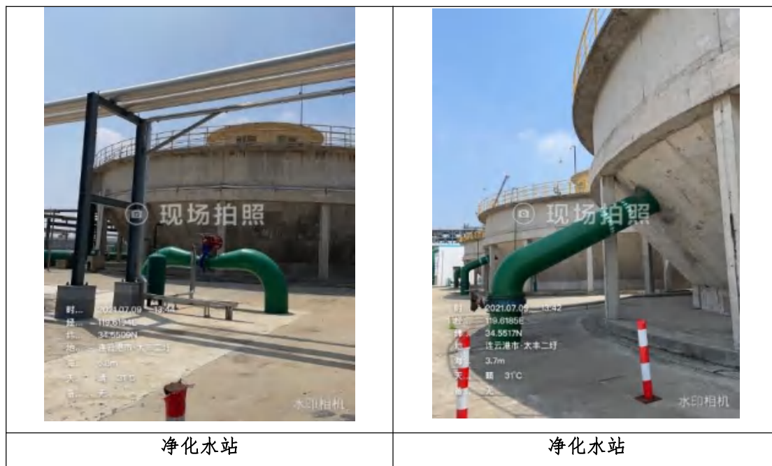
图 5.2-23 净化车站现场排查情况
