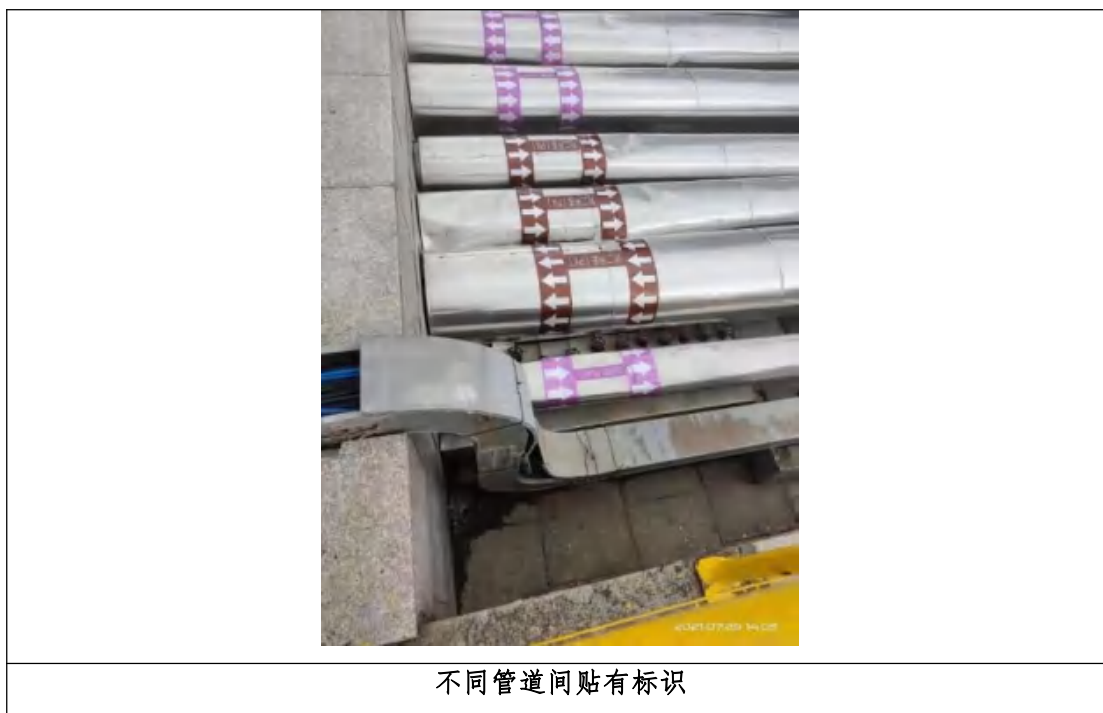
图 5.2-3 中间罐区安全、防渗防护措施
