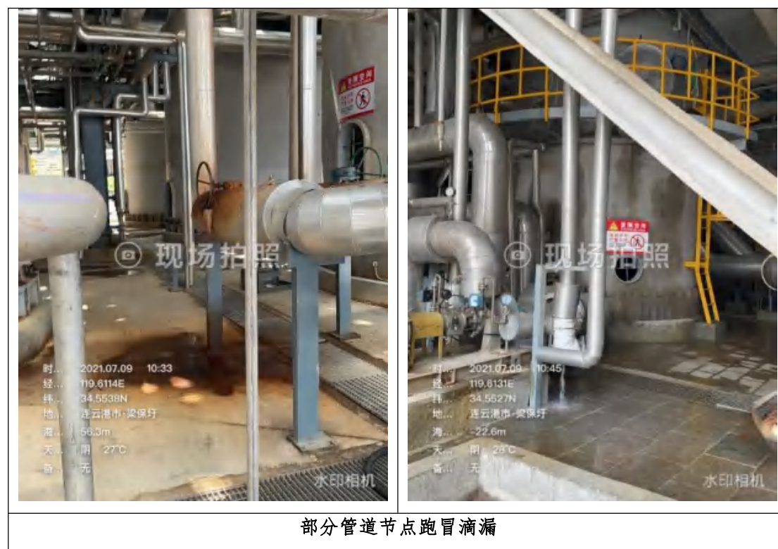
图 5.2-11 运输管道现场排查情况
