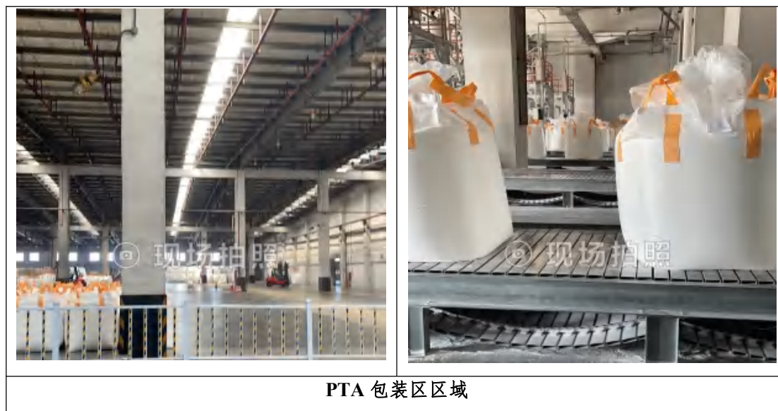
图 5.2-16 PTA 包装区现场情况
