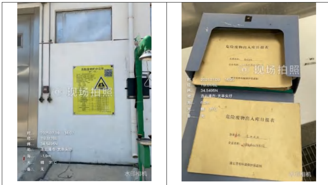
图 5.2-17 危废库现场排查情况
