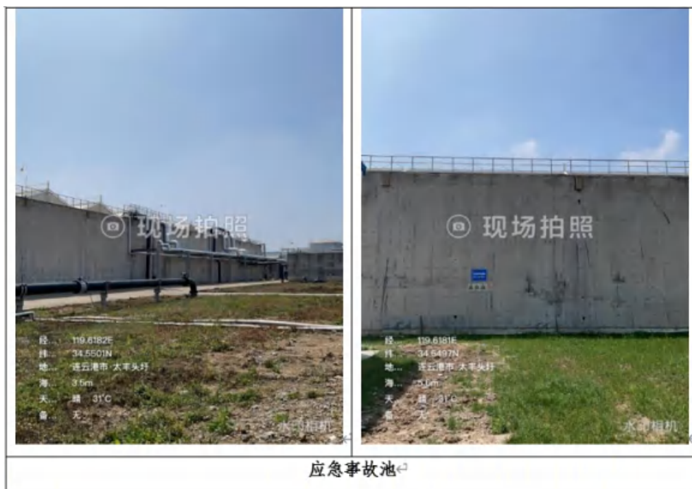
图 5.2-19 应急事故池现场排查情况
