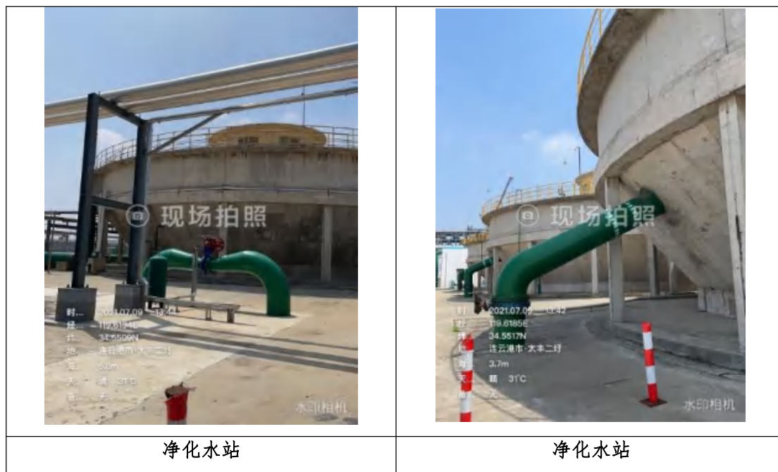
图 5.2-23 净化车站现场排查情况
