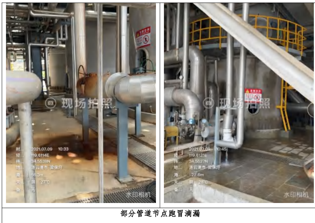
图 5.2-11 运输管道现场排查情况
